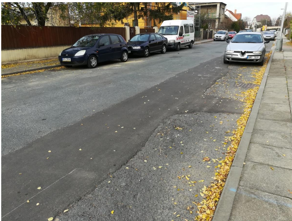
Obrázek 5 ul. Staškova - zapravení po opravě rozvodu plynu
