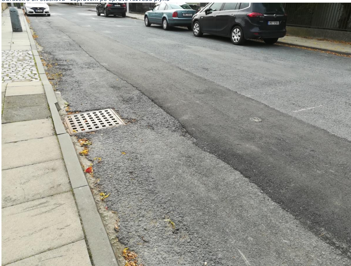
Obrázek 5 ul. Staškova - zapravení po opravě rozvodu plynu
